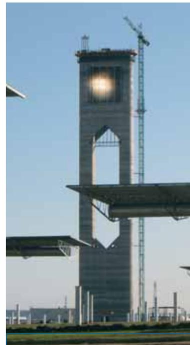
*PS10: los rayos solares son proyectados hacia una torre de 115 metros para calentar un receptor situado a 100 metros de altura*
